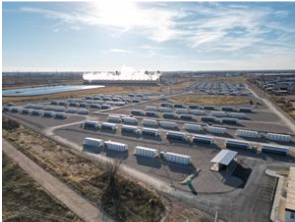
Odessa Data Center Area C
