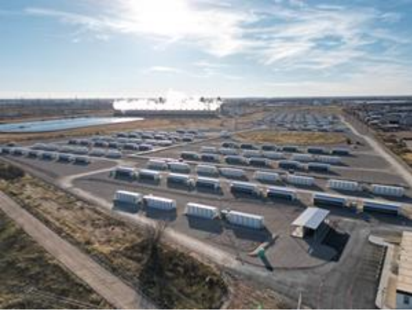
• Odessa Data Center Area C
